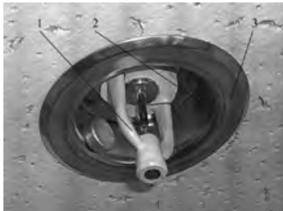
1 – пиротехнический привод; 2 – ороситель; 3 – декоративная чашка
